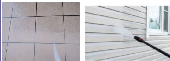
高圧洗浄機での作業
